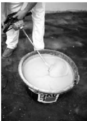
3.25 Ručné miešanie elektrickým miešadlom
