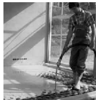
3.29 Liatie poterovej zmesi – zalievanie rozvodov podlahového vykurovania
