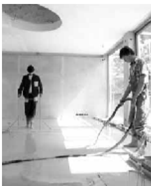
3.26 Liatie poterovej zmesi – strojné spracovanie
