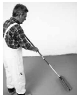
3.31 Spracovanie vrstvy čerstvého poteru prevzdušňovacím valčekom
