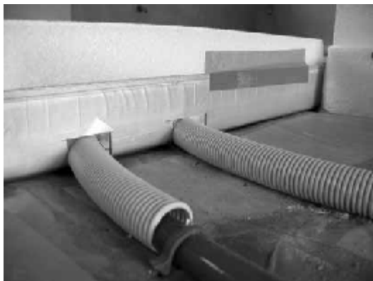
3.13 Prestup rozvodov vykurovacieho systému pohybovou škárou
