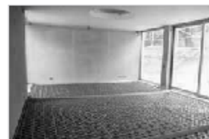
3.20 Rozvod systému podlahového vykurovania fixovaný na špeciálnej separačnej fólii
