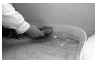
3.16 Položenie okrajovej dilatačnej pásky
