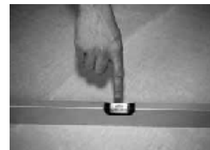
3.35 Meranie rovinnosti poteru vodováhou
