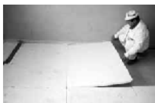
3.17 Položenie podlahových izolačných dosiek
