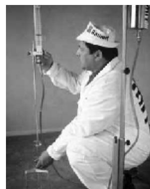
3.21 Zameranie požadovaných výšok poterovej vrstvy
