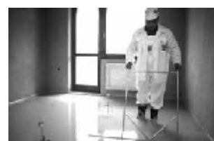
3.30 Spracovanie vrstvy čerstvého poteru nivelačnými tyčami
