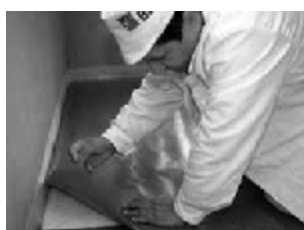
3.18 Založenie separačnej fólie cez fóliu okrajovej dilatačnej pásky
