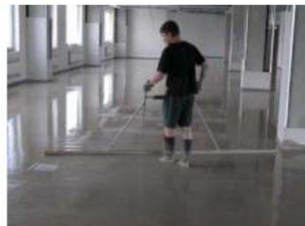
Nivelace a odvzdušňování tekutého potěru pomocí „rádla“.
